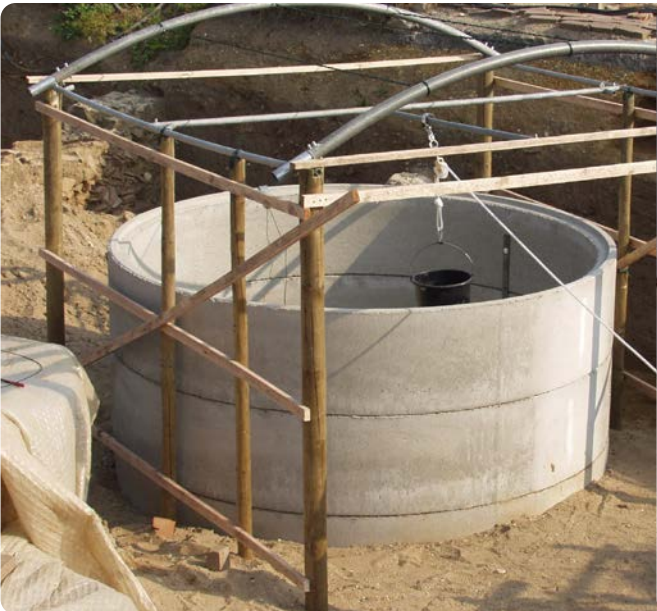
Abb. 51: Verbau mit Betonringen
