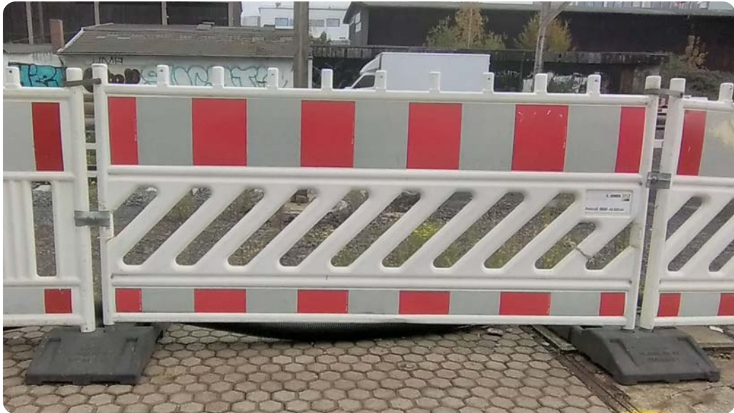
Abb. 20: Absperrschrankengitter zur Absicherung im öffentlichen Verkehrsbereich, Foto: J. Tzschoppe-Komanda
