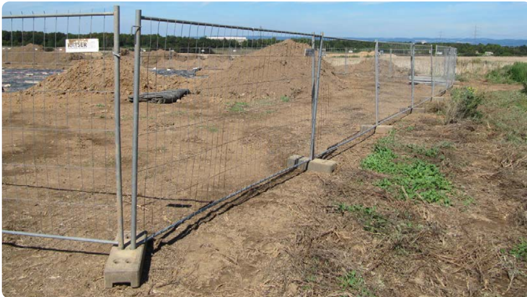
Abb. 21: Bauzaun zur Absicherung der Grabungsfläche, Foto: J. Tzschoppe-Komaiinda
