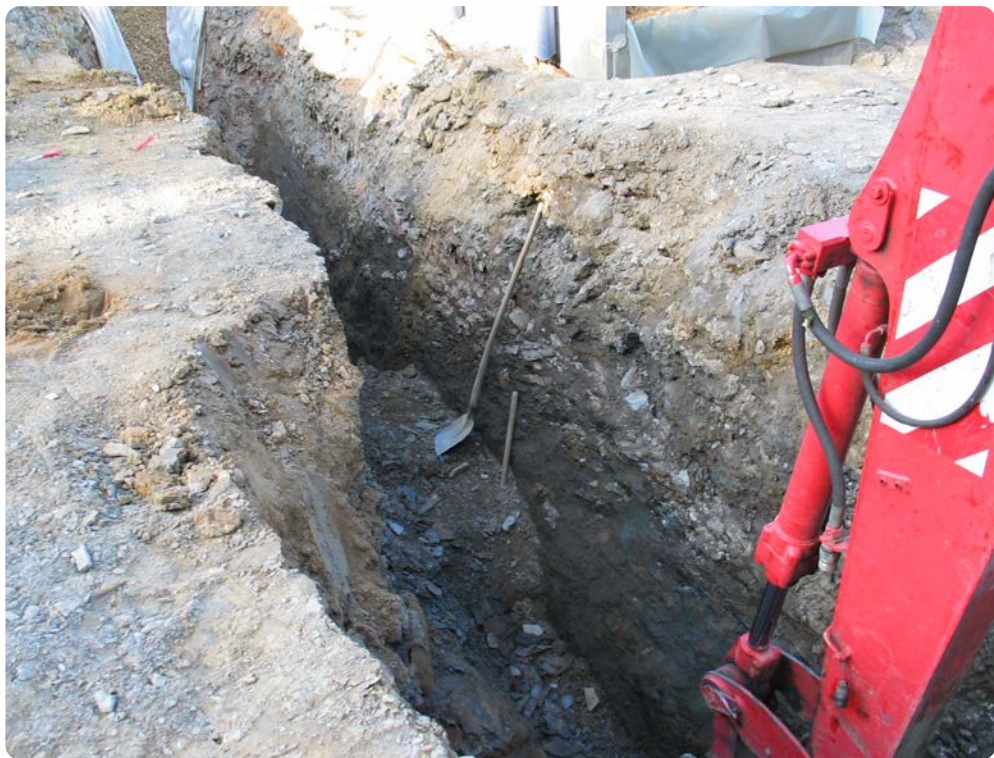
Abb. 34: Abgerutschter Schnitt, Foto: Roger Brandkamp, SVLFG
